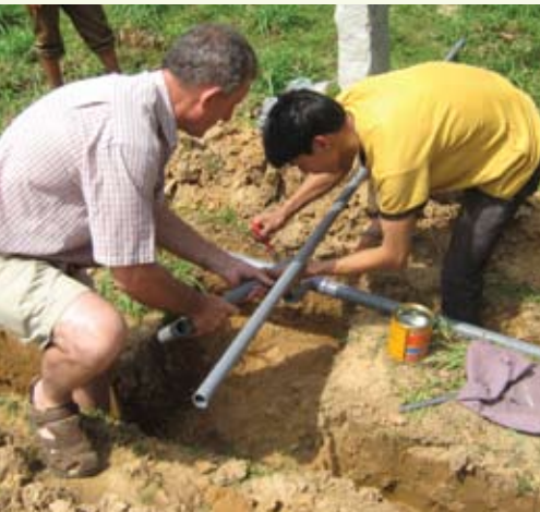
Lắp đặt hệ thống tưới phun Installing sprinkler irrigation system
