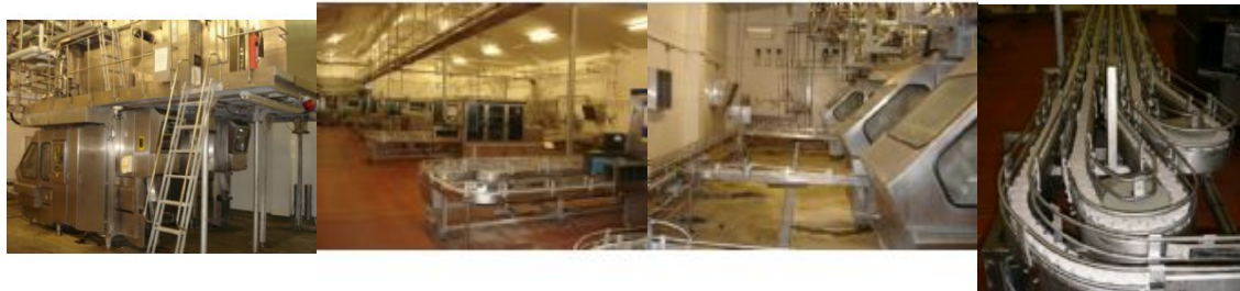
Hình 30: Tủ rót vô trùng
